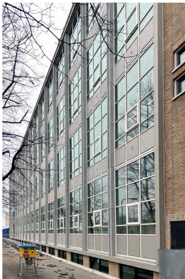
Nieuwe dunwandige GRC gevelkolommen aan de gevel Fruitweg 17 in Den Haag.
