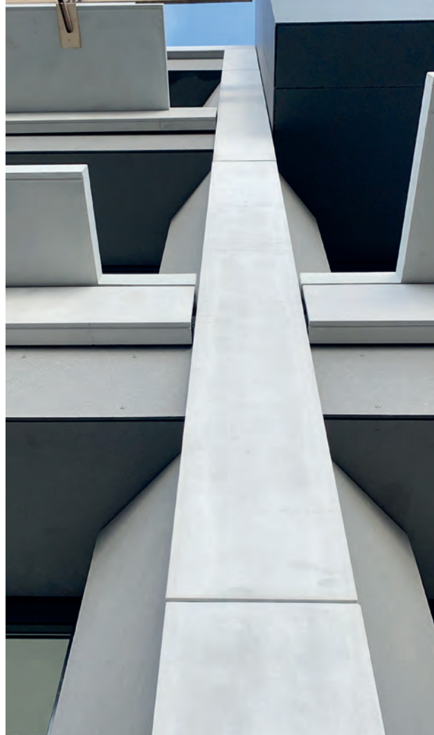
Aan het Willemsplein in Arnhem, is in 2021 de gevel van De Noorman gerenoveerd. Hi-Con leverde de balkons in ultra-hogesterktebeton en GRC gevelelementen.
