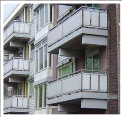
Tävanomainen betoniparveke
